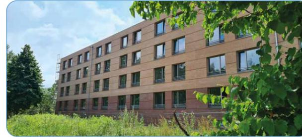
Fertigstellung der Klinkerfassade, die Fenster werden eingesetzt und mit dem Abbau des Gerüsts begonnen.
